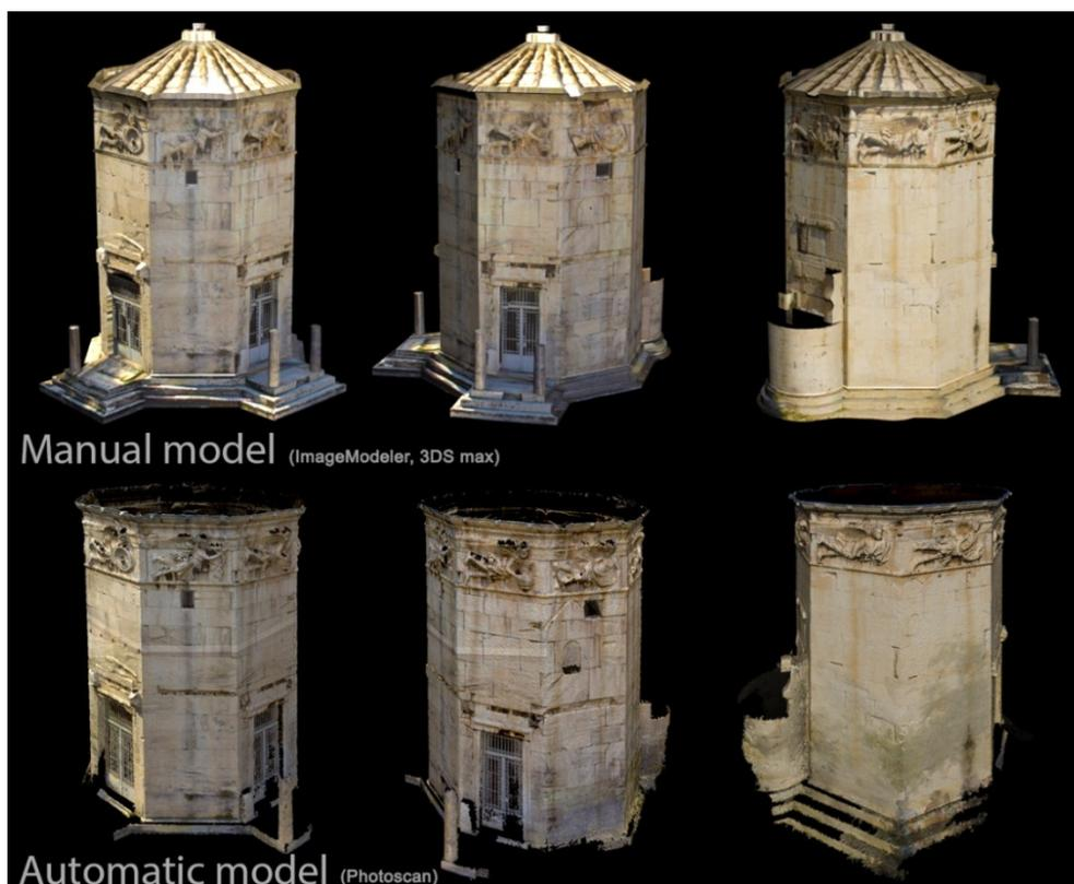
**Fig. 12:** Confronto fra i due modelli reality-based realizzati tramite le due tecniche di image-based modeling.
